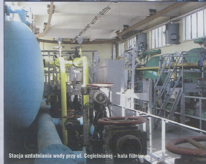
Stacja uzdatniania wody przy ul. Cegielnianej - hala pomp
