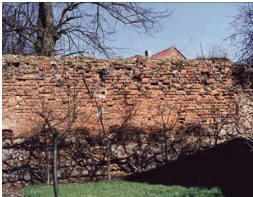
7. Lico zewnętrzne odcinka nr 29 w południowym ciągu murów. Widoczne pozostałości dekoracji romboidalnej z cegieł zendrówek. Fot. K. Milanowski, 2000 r.
