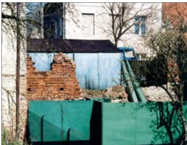
14. Odcinek nr 27 w południowym ciągu murów. Baszta użytkowana jako garaż. W partii frontowej mur zachowany tylko nieco powyżej kamiennego fundamentu. Fot. P. Tuliszewski, 2000 r.
