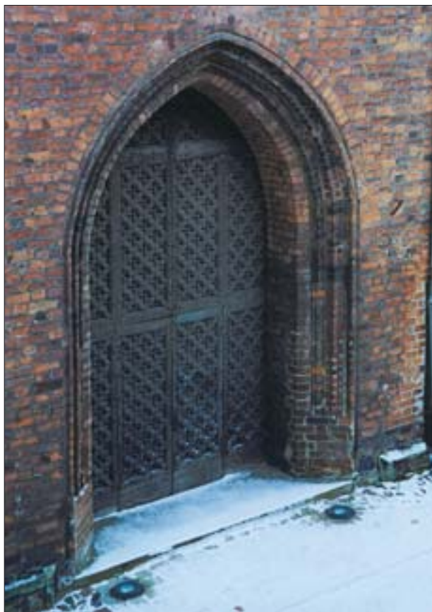
8a. Portal boczny (północny) kościoła Św. Trójcy w świetle dziennym.
