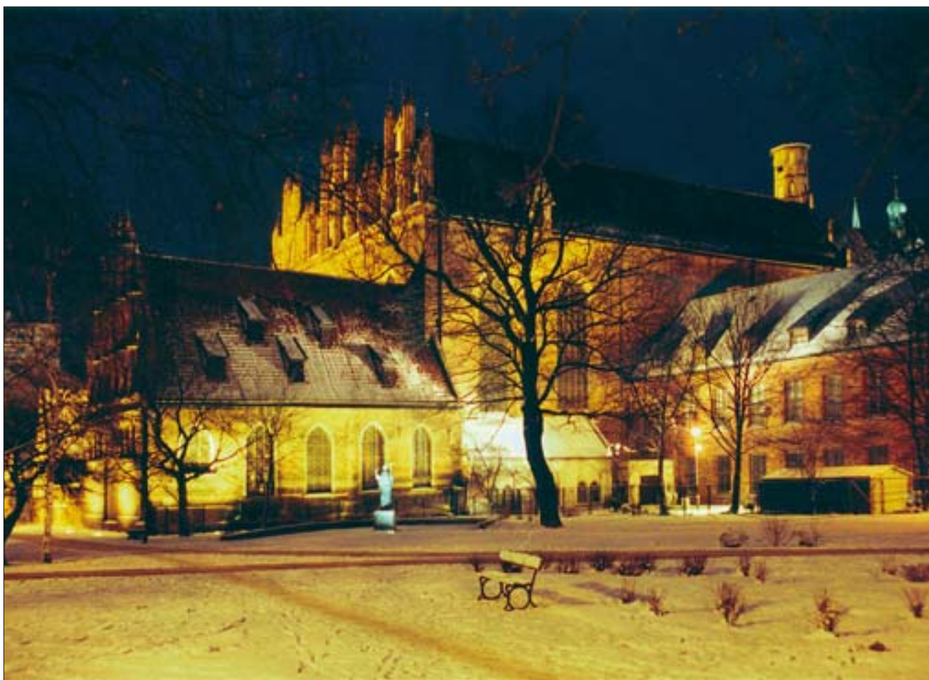
3. Kościół Św. Trójcy i fragment budynku Muzeum Narodowego. Widok ze strony południowo-zachodniej. 3. Church of the Holy Trinity and fragment of the building of the National Museum. View from the south-west.
