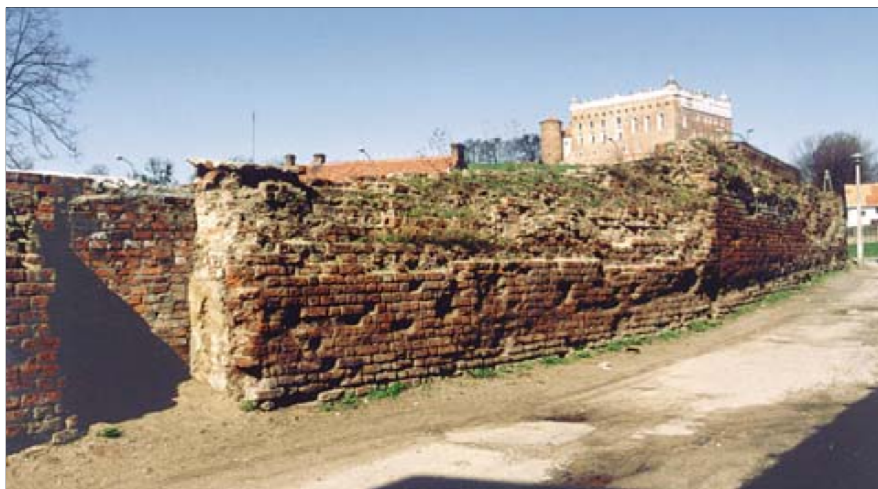
10. Zachodni ciąg murów, strona wewnętrzna (odcinki nr 11 i 12), widok od strony południowej. Fot. P. Tuliszewski, 2000 r. 10. Western sequence of walls, outer side (sections no. 11 and 12), view from the south. Photo: P. Tuliszewski, 2000.
