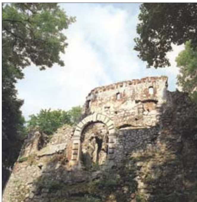
17. Widok bramy zamku w murze obronnym. Fot. S. Michta, 1997 r. 17. View of castle gate in the defence wall. Photo: S. Michta, 1997.
