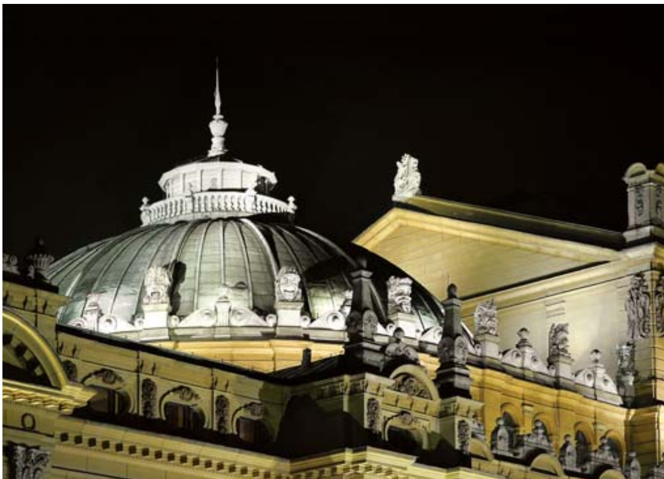
7. Kopuła Teatru im. J. Słowackiego w Krakowie. 7. Dome of the J. Słowacki Theatre in Cracow.
