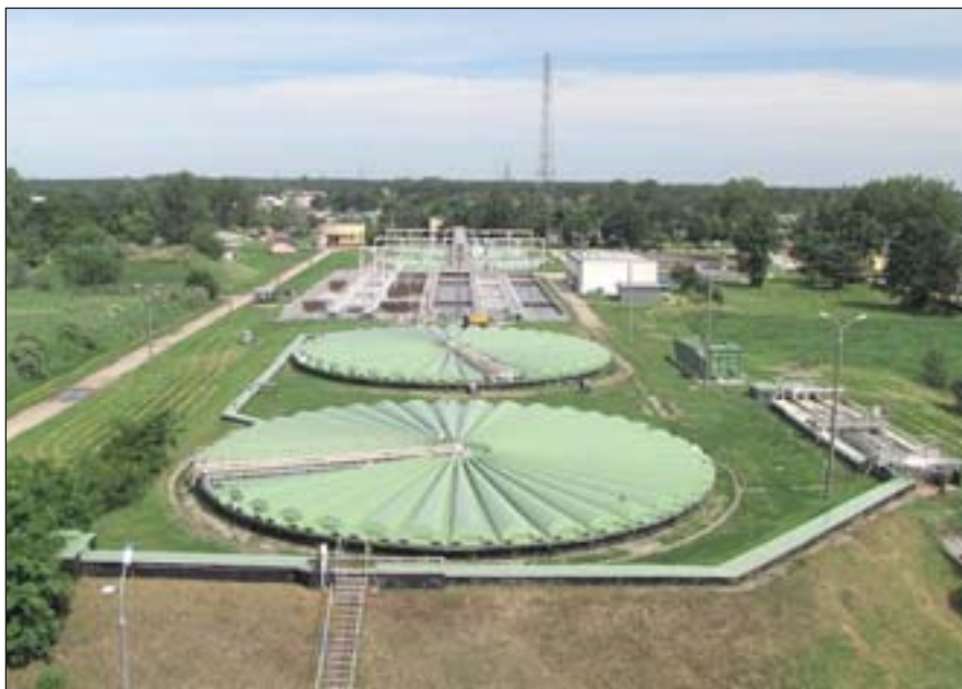
Otwocka oczyszczalnia szykuje się do dużej 20-milionowej inwestycji
