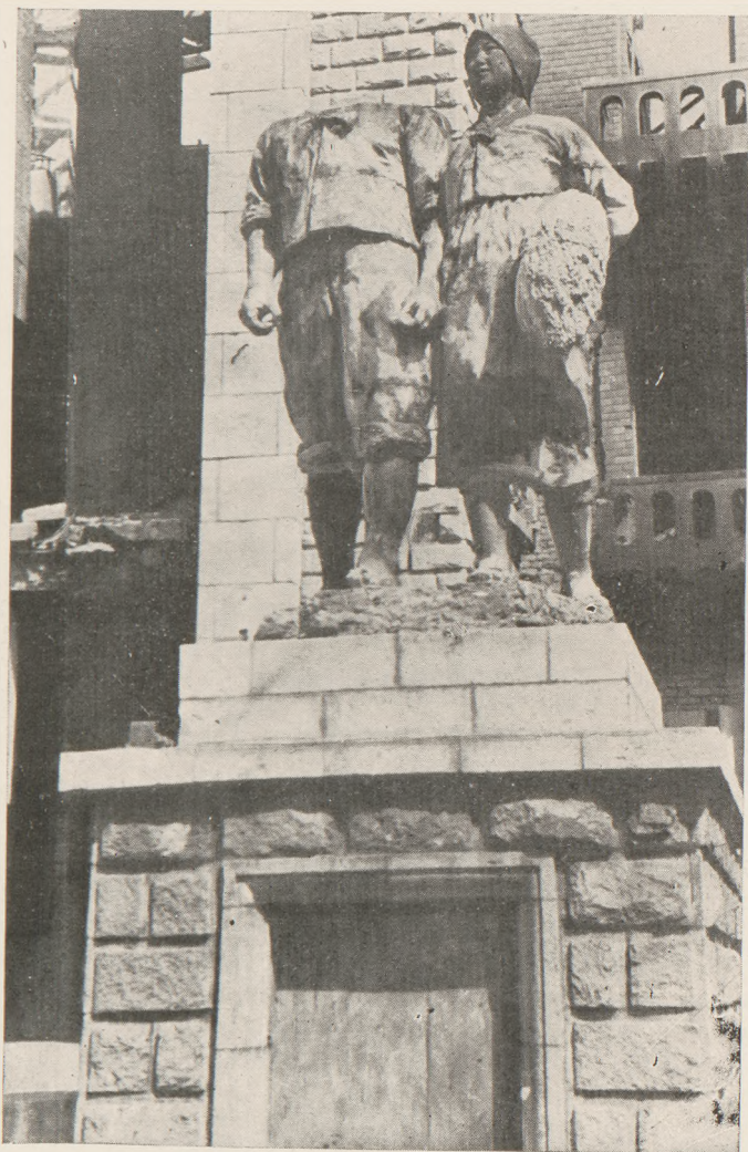
Phenjan. Uszkodzony przez amerykańskie bomby pomnik „Robotnika i chłopka” stojący przed gmachem administracyjnym.
